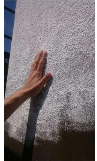
Als Abschluss wird die PU-Fassadenfarbe in gewünschter Farbtonung aufgetragen.
