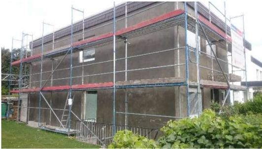
Der tragfähige Untergrund wird mit der **"DIMESEAL® Thermo-PU"** Grundierung vorbehandelt.
