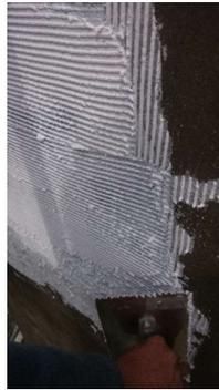
Die PU-Spachtelmasse wird wie eine Wand Putz aufgebracht.
