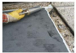
Ferner wurden die Flächenränder (Metall) und der Wandanschluss (Betonstein) ebenfalls mit der PU-Dichtmasse abgedichtet.
