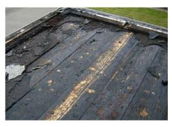
Da man eine "DIMESEAL®" PU-Flüssigkunststoffabdichtung nicht direkt auf eine Holzbohlen-Fläche aufbringen kann, denn der PU-Kunststoff würde zischen den Holzbohlen durchtropfen, musste eine Entscheidung getroffen werden, wie man eine geschlossene Oberfläche erstellt.
