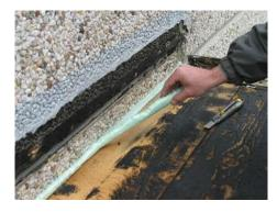
Nachdem der PU-Schaum ausgehärtet war wurde er oberflächenbündig zu den Flächen abgeschnitten.
