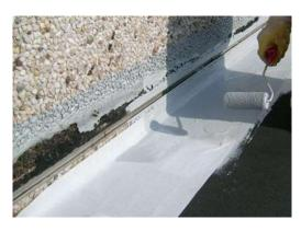
Wie auch bei der herkömmlichen PU-Flüssigkunststoffabdichtung für Bitumenfachdächer wurden die Flächenränder mit den "DIMEFLEX" Gewebestreifen und dem "DIMESEAL®" 250 PU-Flüssigkunststoff dichtlaminiert.
