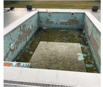
Das rechts gezeigte Schwimmbecken war zum Zeitpunkt des Fotos gerade einmal **“drei Jahre“** alt. Es wurde bereits im **“zweiten Jahr“** schon einmal von innen vollständig saniert. Der Wand-Putz wurde erneuert und mit einer **“handelsüblichen“** Pool-Farbe versehen. Das Becken war dicht aber zerfiel dennoch. Im **“dritten Jahr“** löste sich erneut der Wand-Putz, bildete große Aufblähungen und viel letztendlich wieder ab. Dieses Becken wurde inzwischen abgerissen.
