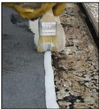
Insbesondere Bereiche rund um Auf- oder Einbauten wie Skimmer, Lampen, Rohre, Abflüsse, Düsen usw. müssen, weil dort auf Grund der unterschiedlichen Ausdehnungskoeffizienten permanent enorme Bewegungskräfte herrschen, vor einer Rissbildung geschützt werden. Die PU-Dichtmassen bilden hier eine dauerelastisch bleibende, stabile Verbindung zwischen den unterschiedlichen Materialien und "puffert" so permanent die thermisch bedingten Bewegungen der verschiedenen Materialien.
