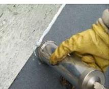
Die Verarbeitung erfolgt mit einer handelsüblichen Kartuschen-Pistole. Man presst die bedarfsgerechte Materialmenge in den jeweiligen Bereich und modelliert die PU-Dichtmasse mit einem Spachtel/Rakel oder einem in "SOLVENT" Lösungsmittel getränkten Pinsel.
