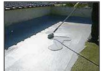
Für die "gewebearmierte PU-Dichtschicht" müssen mind. 2,5 Kg/m<sup>2</sup> vom "DIMESEAL® 250 Plus" PU-Flüssigkunststoff eingesetzt werden.
