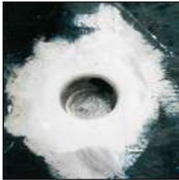
Auf dem Foto links sehen Sie einen mittels **“HYPERSEAL-Expert“** dicht modellierten Kunststoffgully in einer alten Bitumendachoberfläche.
