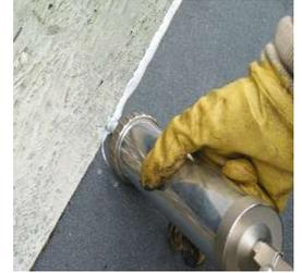
Der Nahtbereich zwischen zwei Materialien (Metallprofile/Folie) erhält durch die PU-Dichtmassen eine bewegungsentlastende und abdichtende Pufferzone.
