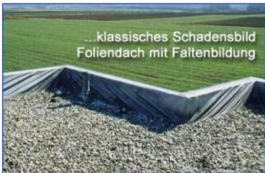
Durch UV- und Witterungseinflüsse verliert die Folie im Laufe der Jahre ihre Weichmacher, wird spröde sowie brüchig und schrumpft. Bei einer geschrumpften Dachfolie stehen zumeist die Dachränder, Ecken und Anschlüsse um Aufbauten herum, erheblich unter Spannung und diese Spannungen sollten beseitigt werden.
