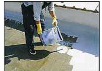
Die 100 cm breiten Gewebeklebebahnen lassen sich optimal mit zwei Personen verarbeiten. Während die eine Person den Anfang der Gewebeklebebahn anlegt, spannt die zweite Person das Gewebe (wie eine Bettdecke) über die mit Flüssigkunststoff vorgelegte Fläche und legt es so faltenfrei auf. Mit weiterem PU-Flüssigkunststoff (ca. 0,8 Kg/m<sup>2</sup>) trinkt man das Gewebevlies und lässt diese Schicht 18 - 24 Stunden trocknen.
