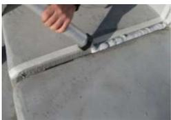
Zur Vorbereitung der PU-Dachbeschichtung gehört eine bedarfsgerechte Planung der benötigten Materialmengen. Für die Menge der benötigten PU-Dichtmasse (Kartuschen) ist die Laufmeterzahl der vorzudichtenden Bereiche, z. B. des Dachrandes, ausschlaggebend. Es gilt die Formel: 6 Laufmeter (mit einer Materialwurst von ca. 1 cm) = 1 Kartusche.
