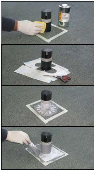
Man beginnt bei der "gewebearmierten PU-Dichtschicht" immer mit den Dachrändern sowie den Umrandungen der Aufbauten (Kamine, Lüftungsrohre, Dachfenster, usw.).
