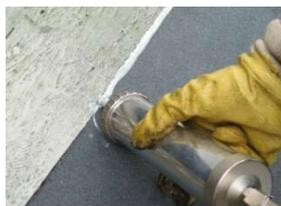
Die Verarbeitung der PU-Dichtmasse erfolgt mittels handelsüblicher Kartuschen-Pistole.
