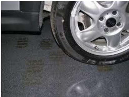
Eine sinnvolle Beschichtung muss daher einen hohen Verschleißwiderstand besitzen, denn die punktuellen Beanspruchungen durch Bremsen und Anfahren ist nicht zu unterschätzen.
