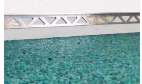
Mit der transparenten PU-Paste "**DIMESEAL® 451 Vertical**" wird zunächst, "noch vor dem Mischen" des Marmor-Kies, mit dem Bindemittel "**DIMESEAL® 451 VERTICAL**" gleichmäßig dünn eingestrichen (ca. 80 - 100 gr/m<sup>2</sup>).
