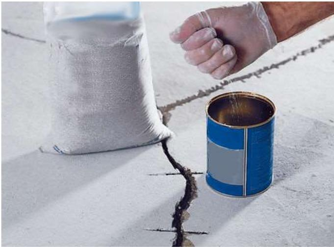
8.) Füllen Sie das Quarzsand-Harzgemisch ein und glätten Sie die Oberfläche mit einem Spachtel
