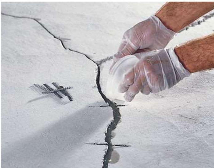
6.) Legen Sie die Metallstabilisatoren in die gefrästen Spalten
