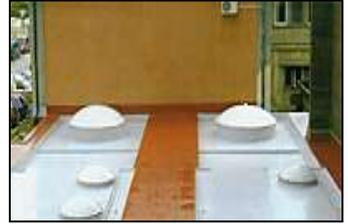
Möchte man nur die gewebearmiert abgedichteten Bereiche der Dachfarbe anpassen trägt man von diesem PU-Flüssigkunststoff eine Schicht mit ca. 250 - 300 ml/m<sup>2</sup>) auf.
