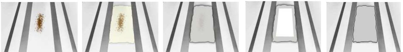
Den Rostbereich schleifen... den Bereich grundieren... Flüssigkunststoff aufbringen... das Gewebe aufgelegt... und das Gewebe tränken.
