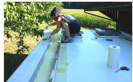
Damit eine vollkommen nahtlose Kunststoffbeschichtung entsteht müssen sich alle Gewebe-Teile **"überlappen"**. Da sich im Bereich der Überlappungen das Gewebevlies in doppelter Stärke befindet muss hier auch mehr vom PU-Flüssigkunststoff aufgetragen werden. Ideal ist, wenn die Überlappungsbereiche falten- und blasenfrei **"nass glänzend"** erscheinen.
