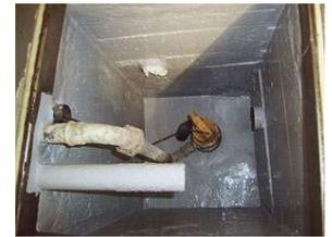
Die fest mit dem Untergrund verbundene, vollflächig gewebearmierte **“DIMESEAL®“** PU-Dichtschicht bildet bei der Abdichtung das Herzstück. Sie kann je nach Nutzung des gespeicherten Wassers, z. B. als Brauchwasser für Gartenbewässerung oder Toilettenspülung, mit einer lebensmittelechten **“PU-Endbeschichtung“** versehen werden.
