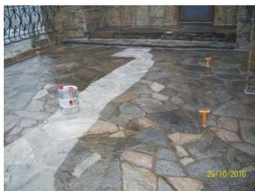
Links sehen Sie eine Terrasse mit undichtem Polygonalplatten-Belag auch diese Fläche wurde transparent beschichtet, sie ist seither dicht. Beachten Sie die intensive Farbgebung des Natursteins die erst durch die Beschichtung zum Vorschein kam.
