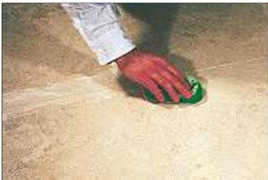
Als Haftvermittler wird der **"DIMESEAL® Primer-T"** mit einem fusselfreien Lappen, so als würde man die Oberfläche mit einem Putzmittel nass reinigen, auf die Fläche **"gewischt"**. Hierfür kalkuliert man 70 - 80 ml/m<sup>2</sup> Material.
