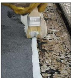
Insbesondere an den unterschiedlichen Materialverbindungen finden auf Grund der **“verschiedenen Ausdehnungskoeffizienten“** der jeweiligen Materialien temperaturbedingt die größten Konstruktionsbewegungen statt. Diese fängt **“HYPERSEAL-Expert“** nachhaltig auf und garantiert eine fest verklebte Abdichtung.
