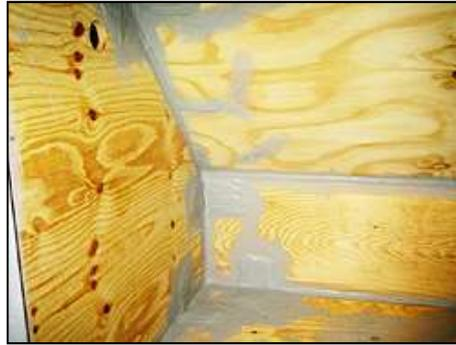
Hier sehen Sie die mit **"Hyperseal-Expert"** abgedichteten und modellierten Eck- sowie Materialübergänge innerhalb des Holzbeckens.
