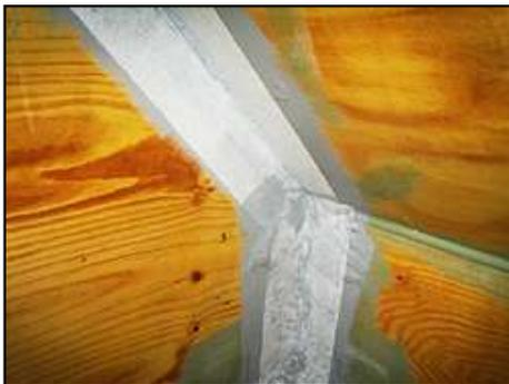
Das kleine Bild zeigt, wie man die Gewebestreifen im Eckbereich anordnen sollte. Bei einem Wasserbecken ist es sinnvoll, wenn sich alle Gewebeteile überlappen damit eine vollflächig nahtlose, geschlossene “Folie“ entsteht.
