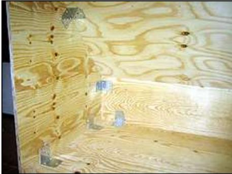
Bei diesem Beckenaufbau wurden zur Optimierung der Stabilität im Inneren des Beckens zahlreiche Metallwinkel montiert.
