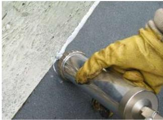
Die Verarbeitung erfolgt mittels handelsüblicher Kartuschen-Pistole. Man presst die bedarfsgerechte Materialmenge in den jeweiligen Bereich und modelliert die PU-Dichtmasse **"HYPERSEAL-Expert"** mit einem in **"SOLVENT"** Verdünnung getauchten Pinsel.
