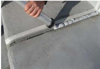
Auch die Nahtbereiche zwischen zwei Materialien (Beton/Gully, Beton/Rohrleitungen, Beton/Kabelschächte, Dehnungsfugen usw.) erhalten durch die PU-Dichtmassen eine **bewegungsentlastende** Abdichtung. Die PU-Dichtmassen sollte abschnittsweise (ca. 1 bis 1,5 Meter) aufgebracht und sofort geglättet bzw. modelliert werden, denn es bildet sich nach ca. 5 Min. ein minimaler Trockenfilm an der Oberfläche.
