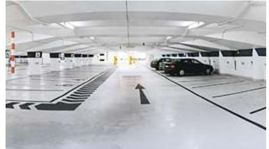
Parkdeck- oder Industriebödenbeschichtungen müssen einen hohen Verschleißwiderstand besitzen, denn die Beanspruchungen durch schwere Lagerbestände sowie durch Bremsen und Anfahren sind nicht zu unterschätzen.
