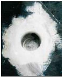
Links sehen Sie einen mit **“HYPERSEAL-Expert“** dicht modellierten Kunststoffgully in einem alten Bitumenflachdach.
