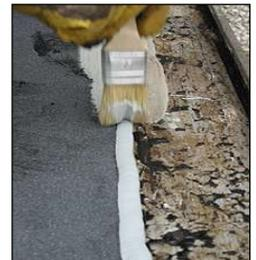
Abschließend sollte man die PU-Dichtmasse 24 Stunden trocknen lassen damit ihre Oberfläche bei der weiteren Verarbeitung nicht mehr beschädigt werden kann. Alternativ kann auch sofort „nass in nass“ weiter gearbeitet werden, jedoch muss man dabei aufpassen, dass modellierte Bereiche nicht beschädigt werden.
