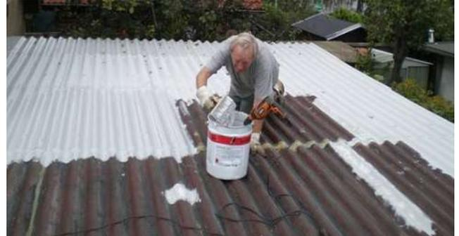
Das Gewebestreifen saugt den zuvor aufgetragenen PU-Flüssigkunststoff auf und bildet nach dem Tränken und der Trocknung eine elastisch, dichte Rissbrücke. Auf Grund der Saugfähigkeit benötigt man im Bereich des Gewebestrieves vom **“DIMESEAL® 250 Plus“** PU-Flüssigkunststoff insgesamt mind. ca. 2,5 Kg/m<sup>2</sup> Material, denn das Gewebe benötigt auf Grund seiner Saugfähigkeit entsprechend mehr Material.
