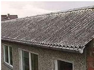
Wellplattendächer gehören zu den kostengünstigen Dachbedeckungen. Das sie schnell und einfach zu montieren sind und eine geringe vorgeschriebene Regeldachneigung von nur 8° Grad benötigen ist ein Vorteil dieser Bedachung.
