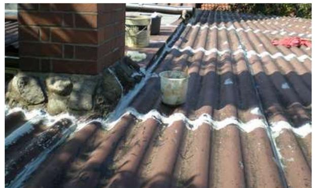
Der PU-Werkstoff **“HYPERSEAL-Expert“** besitzt eine nachhaltige Dehnfähigkeit von bis zu 900%. Er gehört mit zu den wichtigsten Materialien bei der Vorbereitungen einer PU-Dachabdichtung. Der Werkstoff bleibt bis -40°C dauerelastisch.
