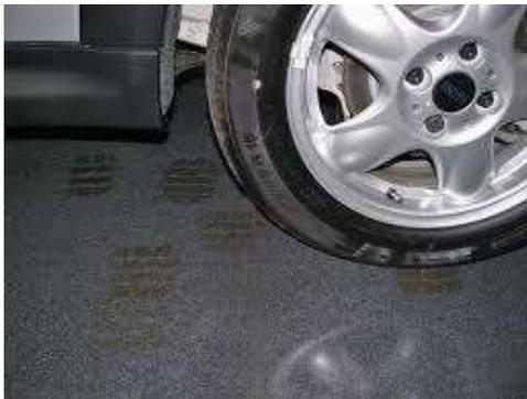
Eine sinnvolle Garagenbodenbeschichtung muss demzufolge einen hohen Verschleißwiderstand besitzen, denn die punktuellen Beanspruchungen durch Bremsen und Anfahren sind nicht zu unterschätzen.
