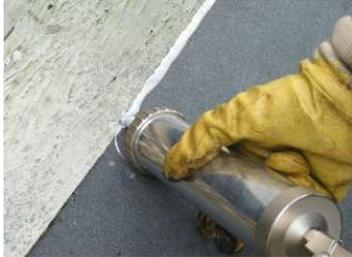
Die Verarbeitung erfolgt mittels handelsüblicher Kartuschen-Pistole. Man presst die bedarfsgerechte Materialmenge in den jeweiligen Bereich und modelliert die PU-Dichtmasse **"HYPERSEAL-EXPERT"** mit einem Spachtel oder Raketel.
