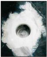
Links sehen Sie einen mit **"HYPERSEAL-Expert"** dicht modellierten Kunststoffgully in einer alten Beton-Estrichfläche.
