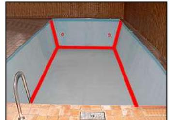
Die Trockenzeit der PU-Dichtmassen beträgt 24 Stunden pro Millimeter Materialstärke. D. h. eine Hohlkehle bei der die Materialstärke am dicksten Punkt ca. 10 mm beträgt benötigt durchaus 10 Tage bis sie vollständig durchgetrocknet ist. Nach 24 Stunden ist die PU-Dichtmasse zwar noch im Untergrund weich aber man kann sie durchaus mit weiteren Werkstoffen überarbeiten.
