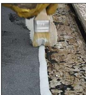
Insbesondere Bereiche rund um Auf- oder Einbauten wie Skimmer, Lampen, Rohre, Abflüsse, Düsen usw. müssen, weil dort auf Grund der unterschiedlichen Ausdehnungskoeffizienten permanent enorme Bewegungskräfte herrschen, vor einer Rissbildung geschützt werden. Die PU-Dichtmassen bilden hier eine dauerelastisch bleibende, stabile Verbindung zwischen den unterschiedlichen Materialien und sie fangen die thermisch bedingten Bewegungen der verschiedenen Materialien nachhaltig auf.
